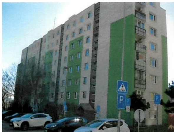
Pohľad na dom
